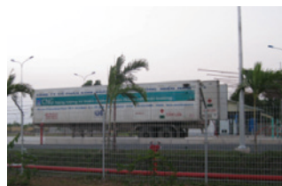
天然ガス供給設備
